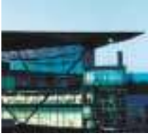
Met Office exterior
